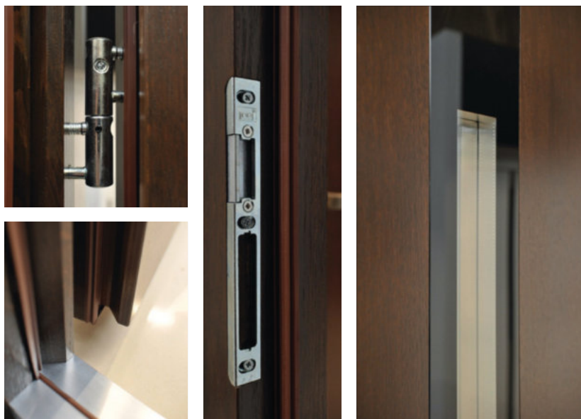
DETALE DRZWI: ZAWIAS, ZACZEP, PRÓG, PRZESZKLENIE
